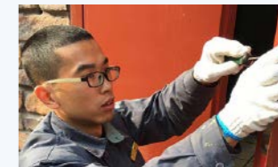
21.杨峰 绍兴 望府·工程维修
