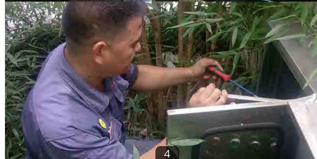
1、抽出积水 3、关闭门窗 2、处理树木 4、检查灯箱
