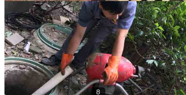
5、清洁下水道 7、疏通下水道 6、疏通积水 8、疏通窰井
